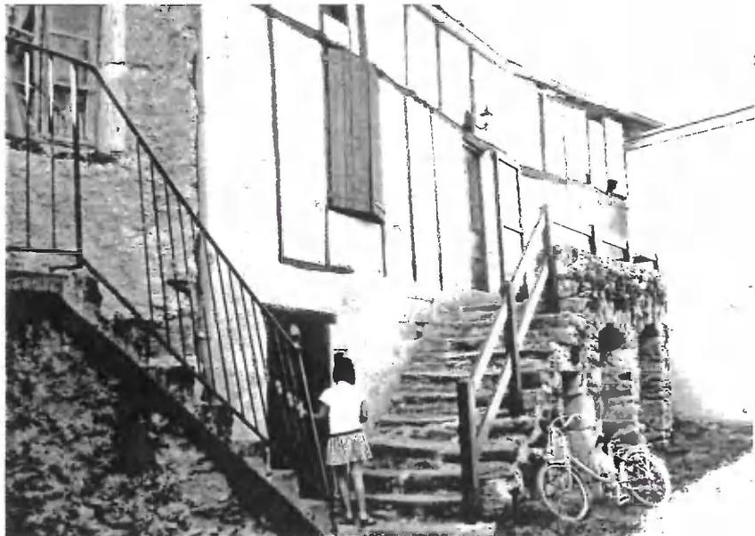
Les pans de bois sont entièrement recouverts lorsque la structure est de qualité médiocre destinée à être protégée. Seules les sommiers ou pièces de repos en contact avec la maçonnerie doivent rester apparents ainsi que les corniches, les entourages de baie et les pièces de bois en encorbellement.
