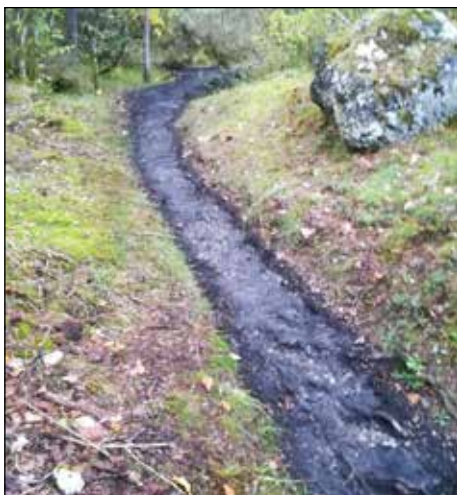
Partie basse du chemin noircie par la boue de l'incendie provenant du causse
