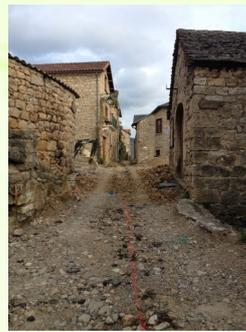
**Mars 2019** : les travaux de décaissement de la rue principale sont bien avancés. De nombreux détails sont réglés au fur et à mesure, en accord avec les habitants de la rue.
