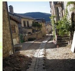
**Rue principale** : Réalisation d'une partie de calade en remplacement des marches en béton, et restauration du muret attenant.
