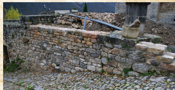
Reconstruction en pierres sèches du muret de la rue des Muriers (place de l'église) .
