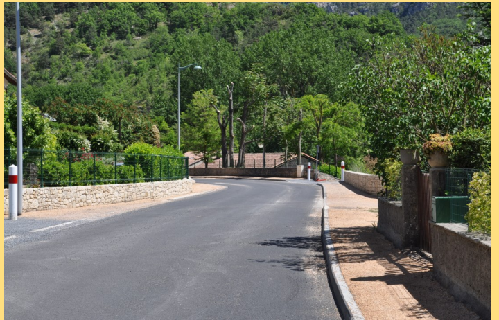
Aménagement de la traverse de Saint Pal
