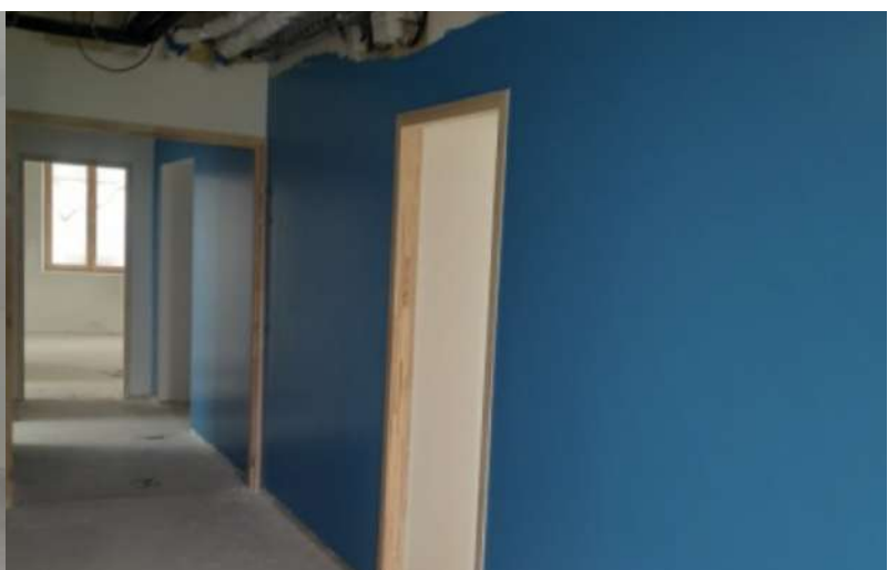
COULOIR ET COWORKING EN FOND
